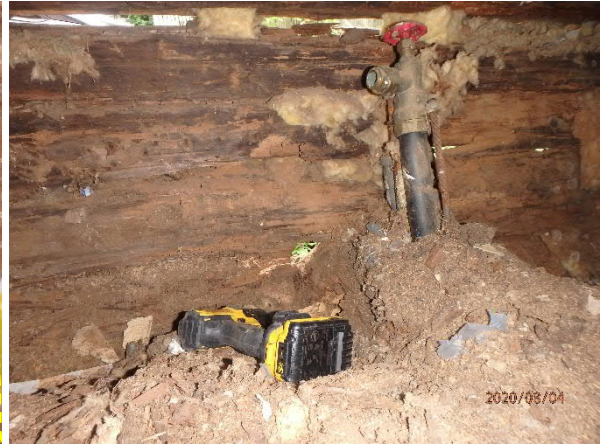
Kuva 5. Keittiön pohjoisseinällä entisen vesipisteen kohdalla havaittiin alapohjan tasolta alkava laho- ja hyönteisvaurioalue, joka nousi vesipisteen kohdalla seinän puoliväliin 7-8 hirsikerroksen tasalla. Alapohjan tasalla vaurio jatkui luoteisnurkalta väliseinän yli huoneen puolelle.
