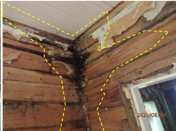
Kuva 6. Aktiivinen kattovuotokohta huoneen ja eteisen väliseinän kohdalla suoraan ulkoseinänlinjan kohdalla on aiheuttanut nurkan ympärille laho- ja hyönteisvaurioita yläpohjasta alaspäin 5-6 hirsivarvin korkeudelle.
