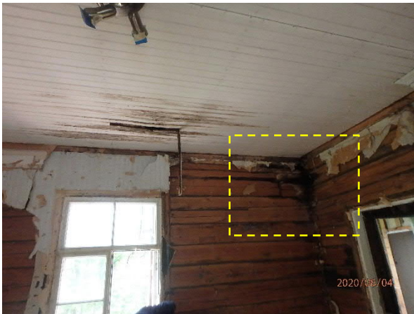
Kuva 6. Aktiivinen kattovuotokohta huoneen ja eteisen väliseinän kohdalla suoraan ulkoseinänlinjan kohdalla on aiheuttanut nurkan ympärille laho- ja hyönteisvaurioita yläpohjasta alaspäin 5-6 hirsivarvin korkeudelle.
