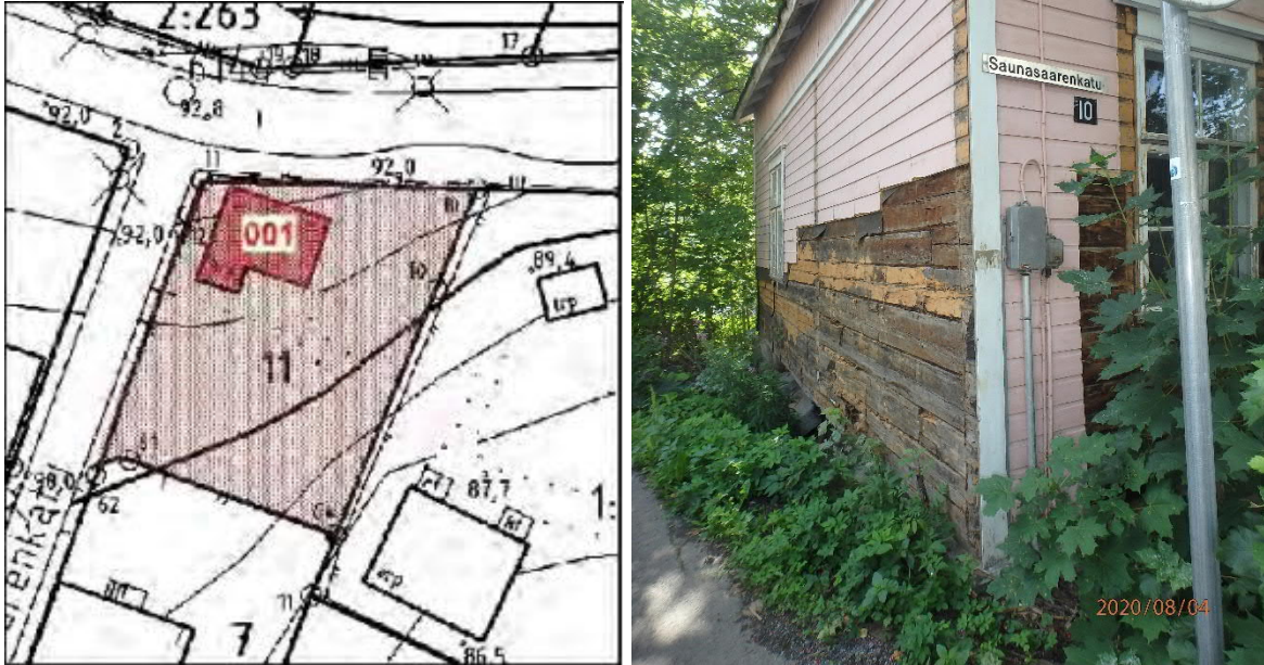
Kuva 1. Tahmellan viertotien ja Saunasaarenkadun kulmassa sijaitseva rakennus 001 on ollut asumaton vuodesta 2005 lähtien.
