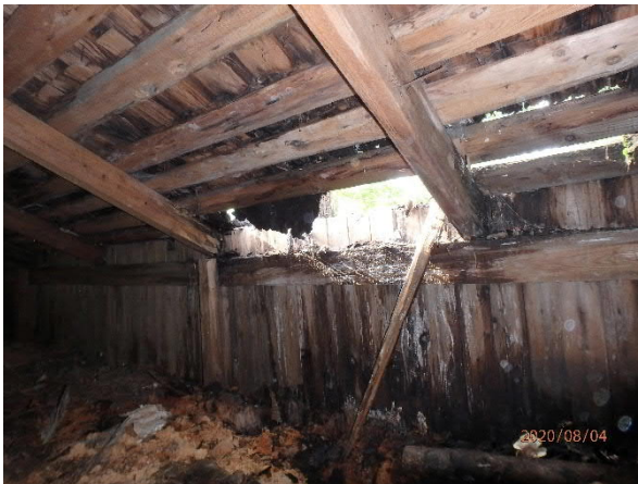
Kuva 11. Ulkoseinälinjan päällä oleva vuotokohta oli romahtanut auki purkutöiden yhteydessä. Alapuolella olevat rakenteet olivat vesimärkiä ja kohdassa oli näkyvää sienirihmastoja sekä vaalea itiöemä.
