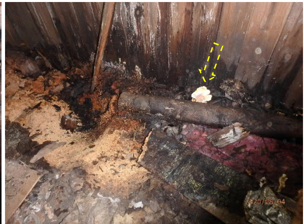
Kuva 11. Ulkoseinälinjan päällä oleva vuotokohta oli romahtanut auki purkutöiden yhteydessä. Alapuolella olevat rakenteet olivat vesimärkiä ja kohdassa oli näkyvää sienirihmastoja sekä vaalea itiöemä.
