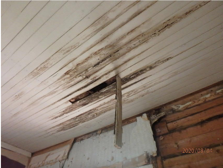
Kuva 10. Huoneen katossa näkyvää vuotokohtaa oli joskus aiemmin paikattu bitumikermillä, mutta väliaikainen korjaus oli alkanut vuotaa uudelleen.
