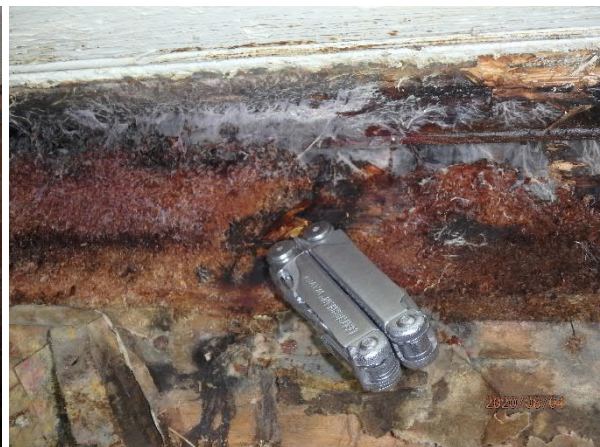
Kuva 7. Kuvan 7 vauriokohta jatkuu eteisen ulkoseinälle ristinurkan yli. Kohdassa hirsi on vesimärkkää. Hirren pinnasta pahvien poiston jälkeen paljastuneen rihtmaston ja yläpohjan tasassa näkyvän
